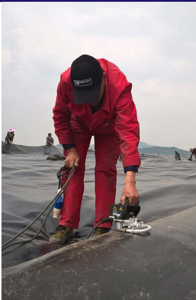
156.617 (230 V) 156.204 (120V) Heizkeil, 56 x 36 mm, Kupfer, mit Prüfkanal
