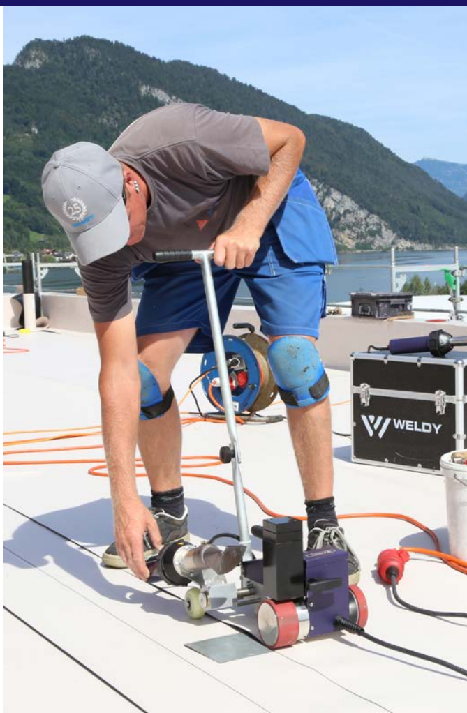
123.287 Buse pour le soudage par recouvrement, 40 mm
